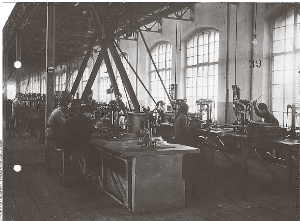
Новая мастерская инструментального цеха Путиловского завода. 1927 г.
