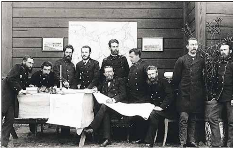
Николай Михайлович Тихомиров с инженерами-строителями моста через Обь, ок. 1893–1895 гг.
