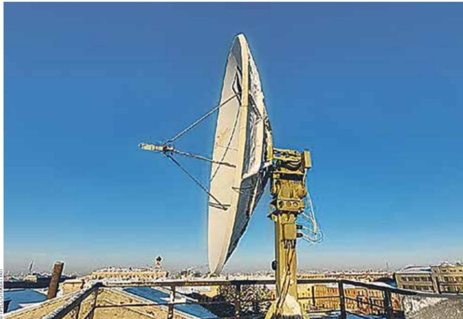
Станция приёма спутниковых данных
